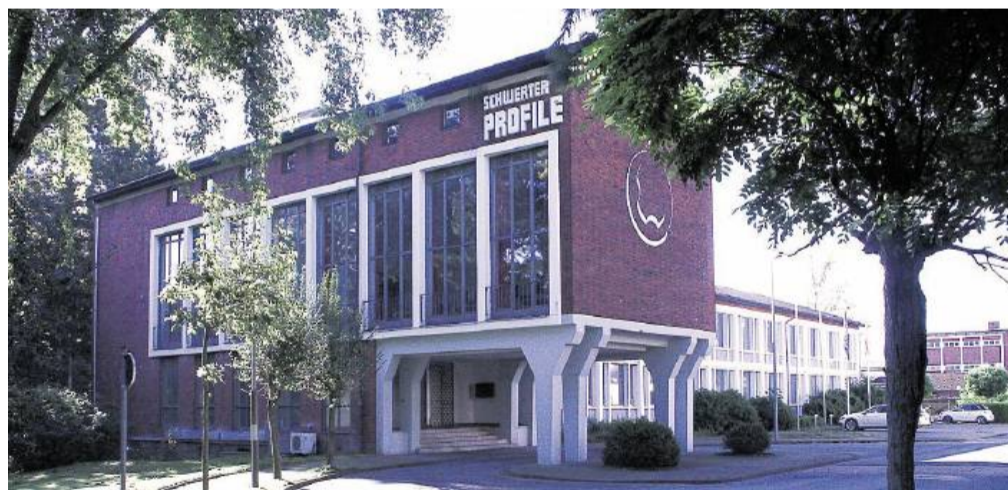
Ein Denkmal der Schwerter Industriegeschichte: Der altherwürdige Hoesch-Verwaltungssitz an der Eisenindustriestraße wird zur hippen „Factory4“. Noch ist Platz für Büros vorhanden.
